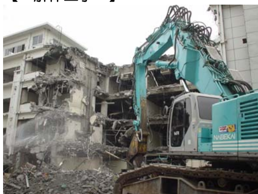
(写真：1号棟解体の様子)
